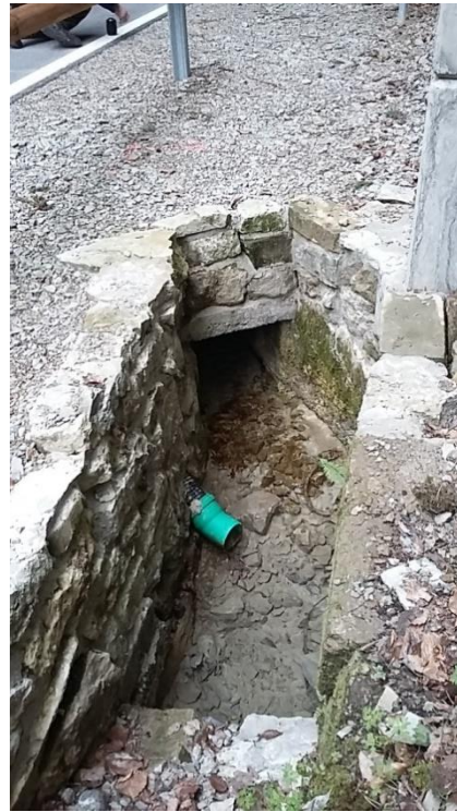
Abb. 19: Krenal nächste offene Wasserstelle vor dem Küllestedter Tunnel
