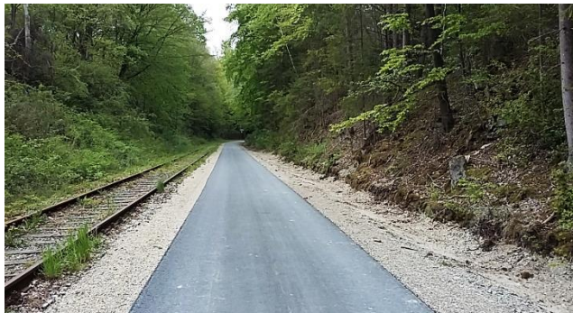
Abb. 17: Kanonenbahn-Radweg mit Küllestedter Tunnel
