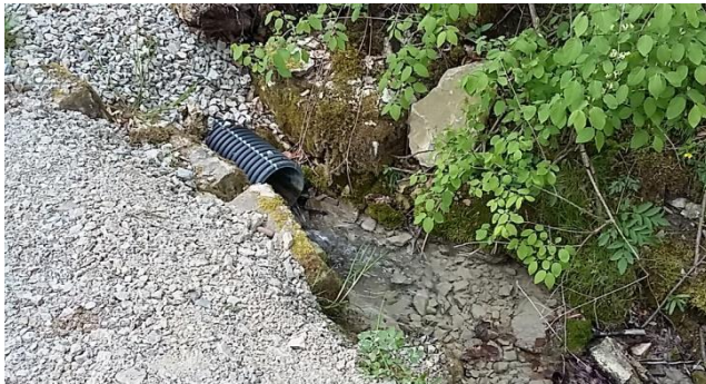
Abb. 18: Verrohrter Quellbach parallel zum Radweg
